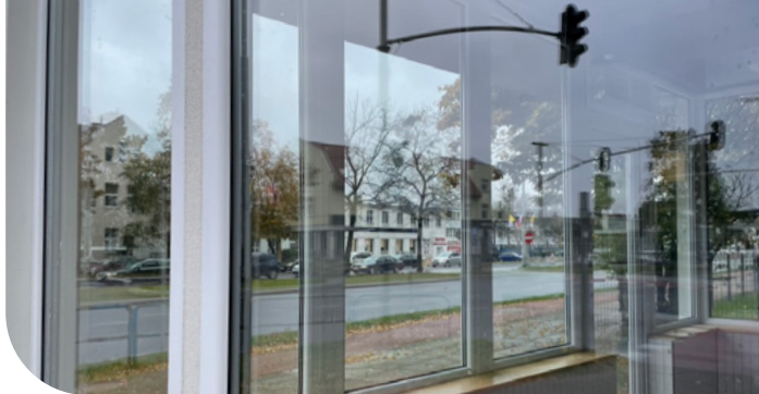
FOT. 5. Catkowicie przeziernie przeszklenia często są przyczyną wielu kolizji, szczególnie jeśli umieszczone są na przestrzał lub narożnie [Źródło: Lucyna Piłacka]
